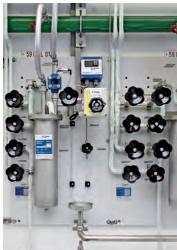
Probenaufbereitung mit Kühlung und Druckreduzierung Sample preparation with cooling system and pressure reduction
